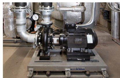
施設内で多様に活躍するグルンドフォスのポンプ (写真は直動式片吸込みポンプNBG)
