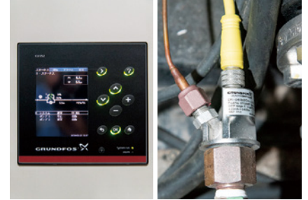
約90%ものポンプ電力低減に貢献した差圧制御の制御盤と小型でも大きな役割を担うセンサ
